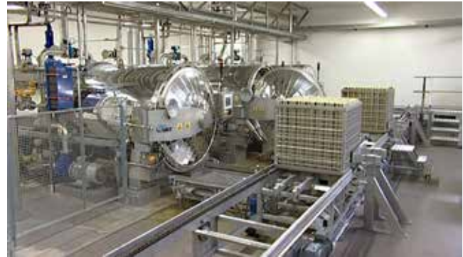
Система транспортировки с фиксированными конвейерами
